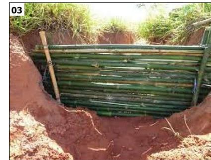
03 RETENTOR DE SEDIMENTO TIPO PALIÇADA
